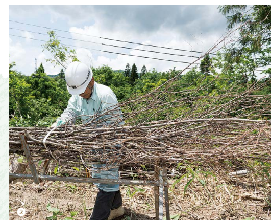
①粗朶沈床は明治初期にオランダから日本に伝えられた。「柵掻き（しがらぎ）」と呼ばれる組み立て作業はすべて手作業で行われる ②結束台で長さをそろえた粗朶を結束することを「粗朶束（まるけ）」という ③葉が落ちてから芽吹く前に木を切ると品質が向上し、良くなる粗朶ができる
